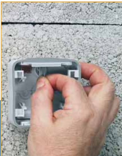
Τραβήξτε τη μεμβράνη εσωτερικά με το χέρι μέχρι να κοπεί
